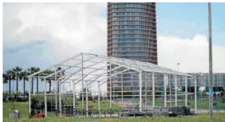
La estructura de una de las casetas ya montada.
