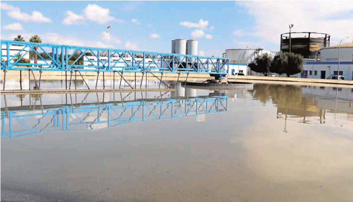
Instalaciones depuradoras de El Copero, que van a sufrir una transformación enorme gracias a una inversión superior a los 34 millones
