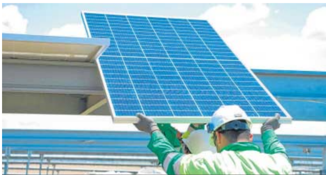
Trabajos de montaje de una planta fotovoltaica.
