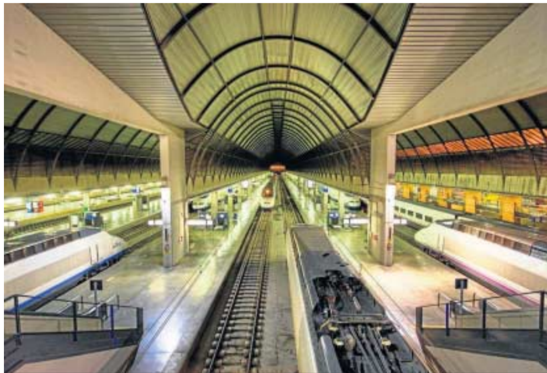
Vista general de la zona de andenes de la estación de Santa Justa.
