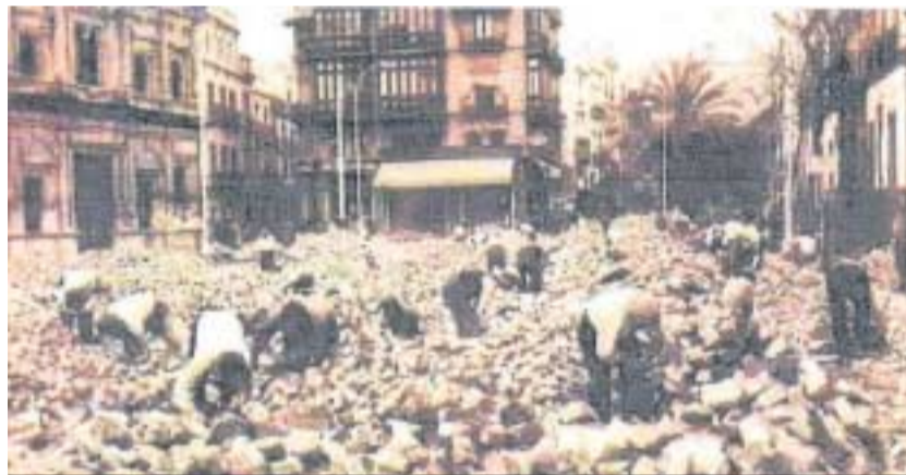
Labores de colocación y relabrado de adoquines en la Plaza de San Francisco.
