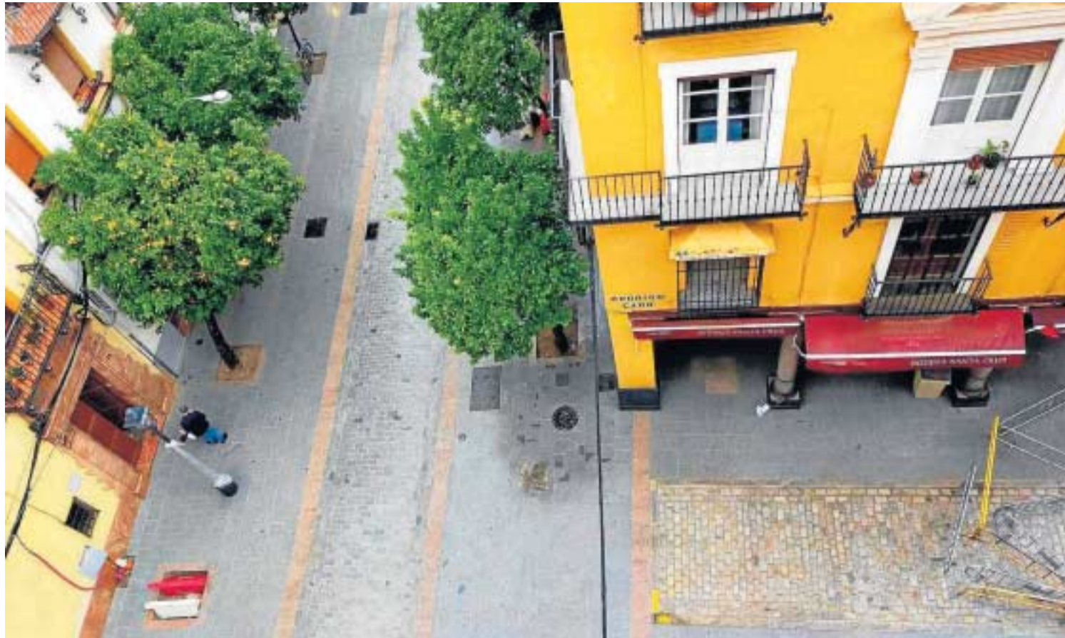
Diferencia del adoquín gris instalado en Mateos Gago, y el coloreado de Gerena que se ha mantenido en la calle Rodrigo Caro.
