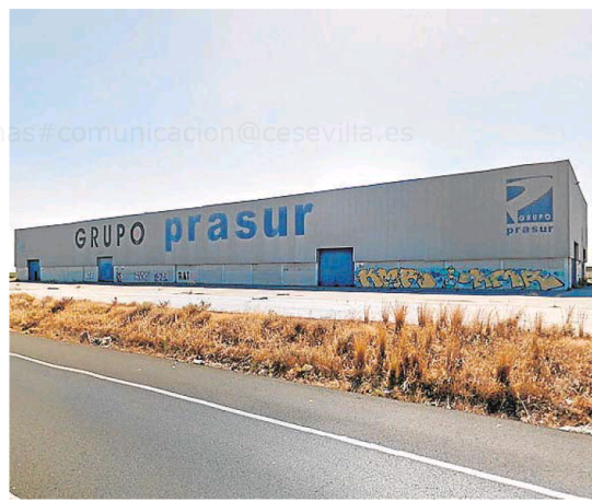
Antiguas instalaciones de Prasur, donde se instalará ahora Postemel
