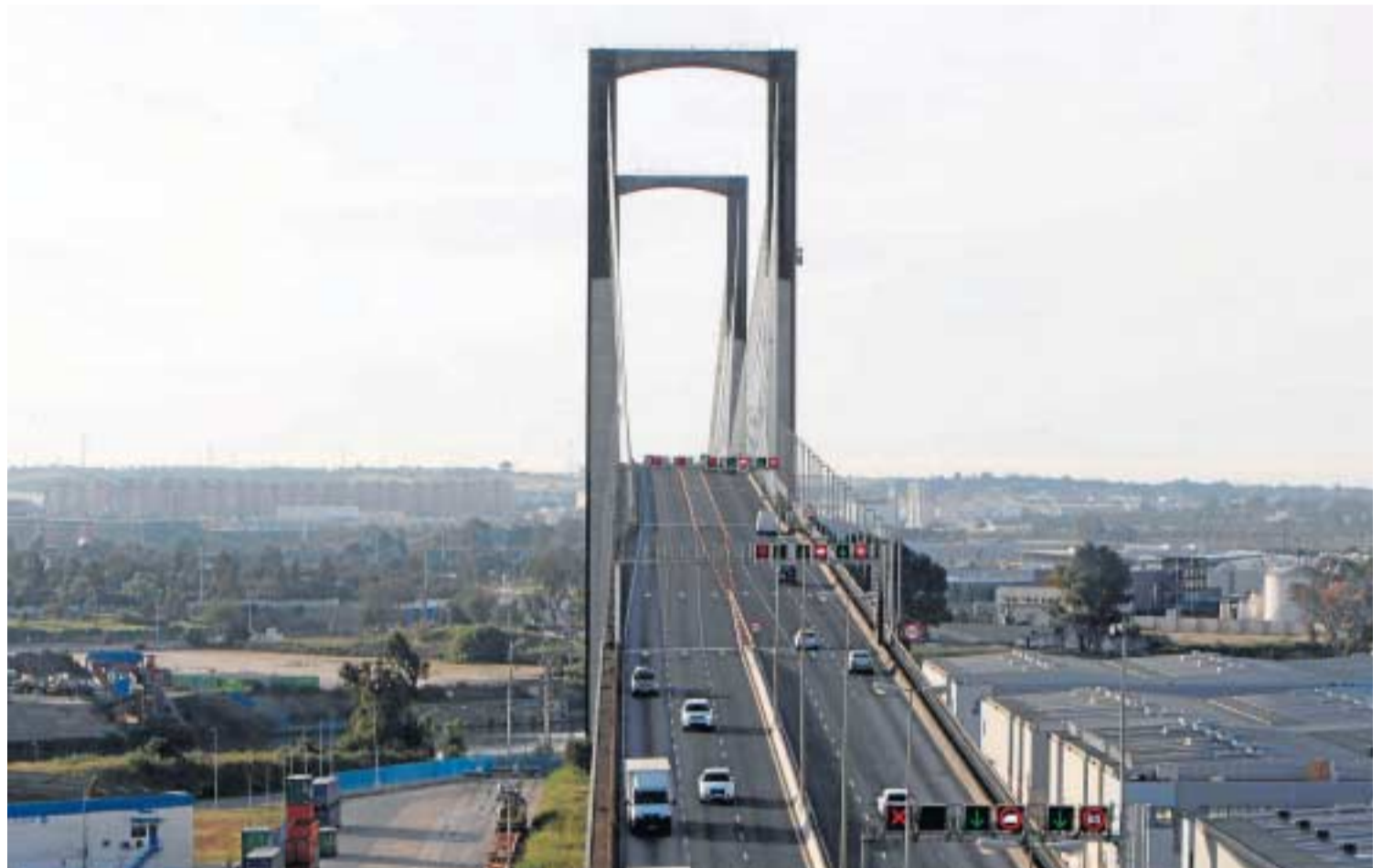
Circulación en el puente del Centenario de la SE-30.
