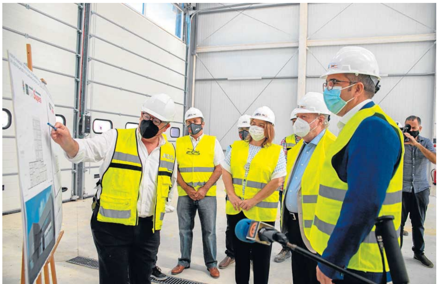
Visita a las obras del nuevo parque de bomberos.
