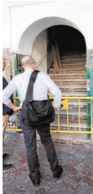
La escalera que se va a restaurar
