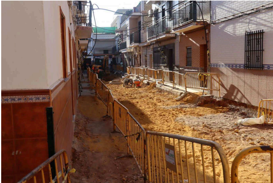
Actuaciones en Torreblanca.
