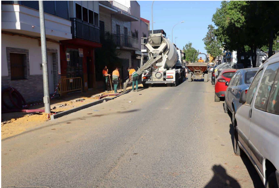
Actuaciones en Torreblanca.
