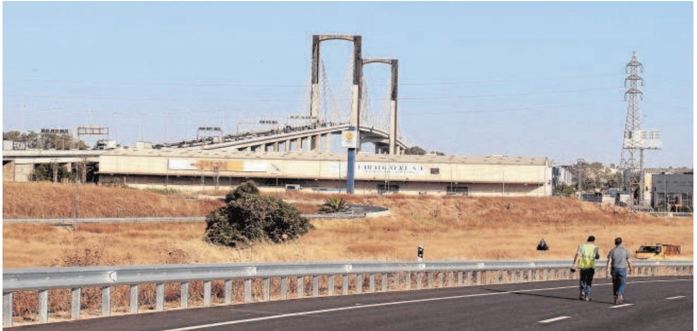
Las obras del puente del Centenario arrancarán en unos días y el tráfico se desviará por la zona del Puerto // MANU GÓMEZ
