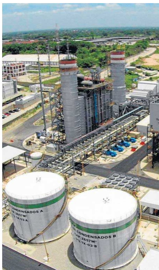
Planta de cogeneración A3T construida por Abengoa en México.
