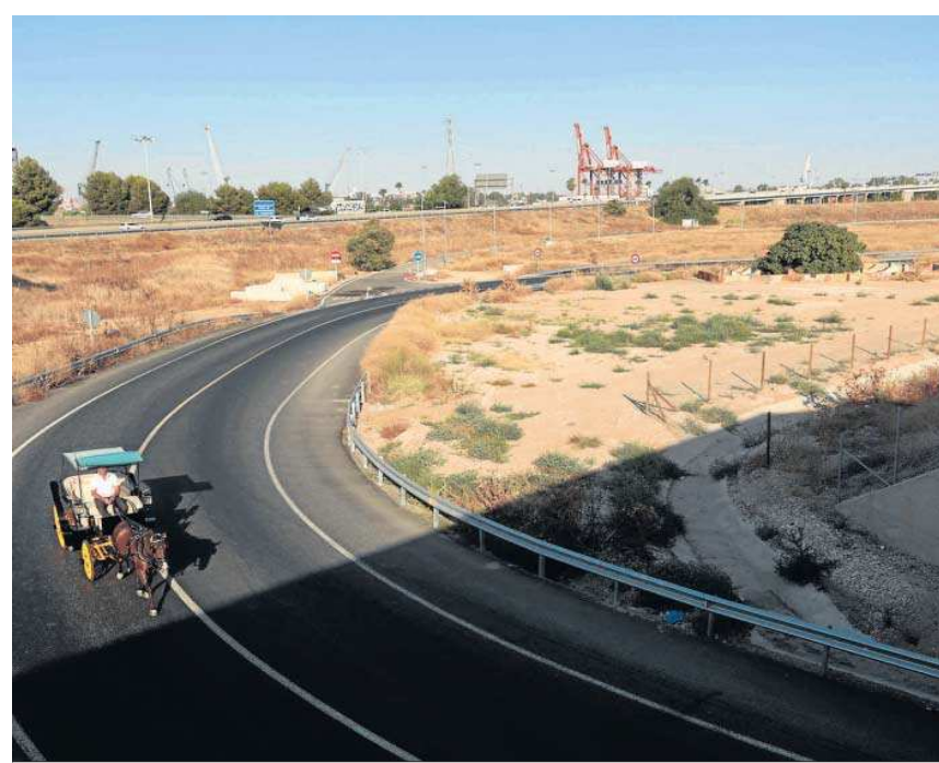
Los desvíos habilitados para el tráfico durante las obras en el Centenario.
