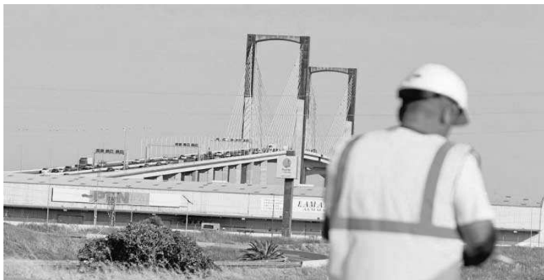
Un operario trabaja junto al Puente del Centenario.
