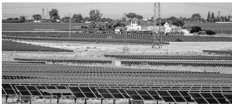
Don Rodrigo II, uno de los parques fotovoltaicos de Alcalá de Guadaíra junto a la carretera de Utrera.
