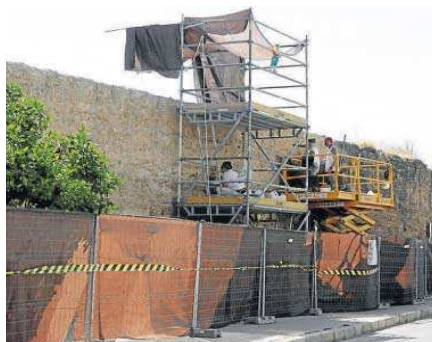
MURALLA DE LA MACARENA | 931.000€
