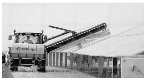
Un operario limpia las placas con un rodillo especial, en Guillena.
