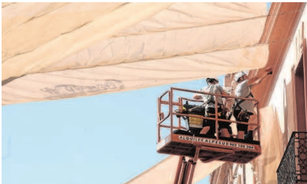
Operarios instalando los toldos en las calles del Centro el verano pasado // RAÚL DOBLADO
