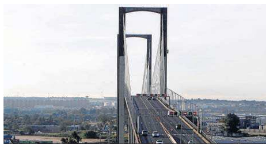
Vista aérea del puente del Centenario con cuatro carriles más el reversible. JOSÉ ÁNGEL GARCÍA
