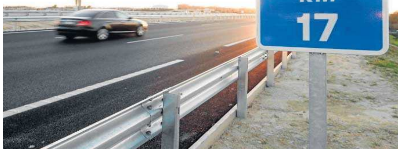
Un tramo ya terminado de la SE-40, a su paso por Dos Hermanas.
