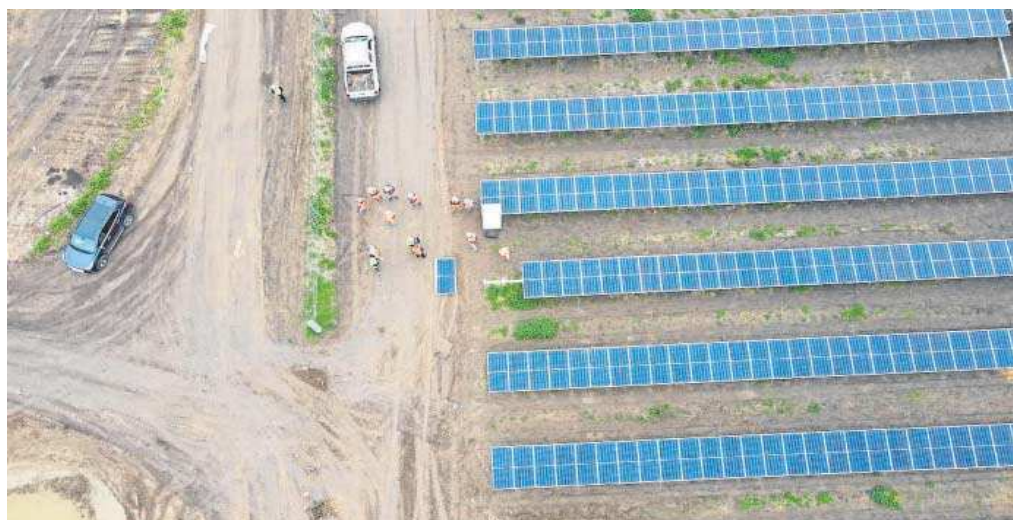
Colocación del último panel fotovoltaico de una planta solar de Endesa.
