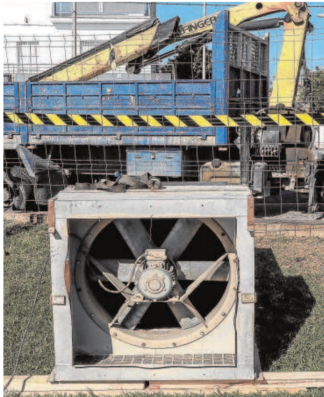
Revisión de la red de saneamiento de la zona afectada // EFE
