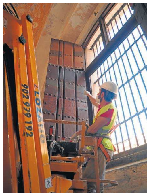
Un operario muestra la recuperación de la carpintería de madera.
