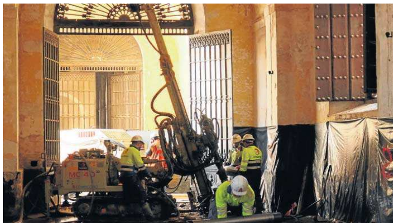
Trabajos en el interior de la Fábrica de Artillería.
