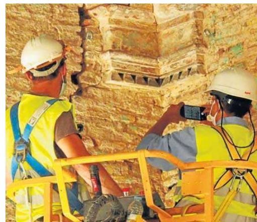
Técnicos fotografían los paramentos rehabilitados.
