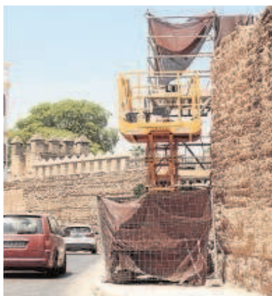
Rehabilitación de la muralla de la Macarena
