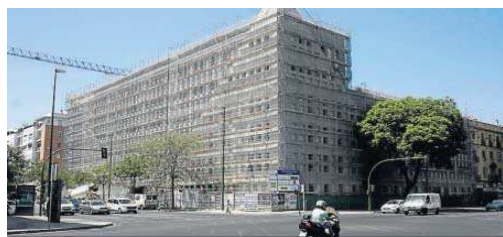
El hotel que se construye en la antigua sede de Abengoa.
