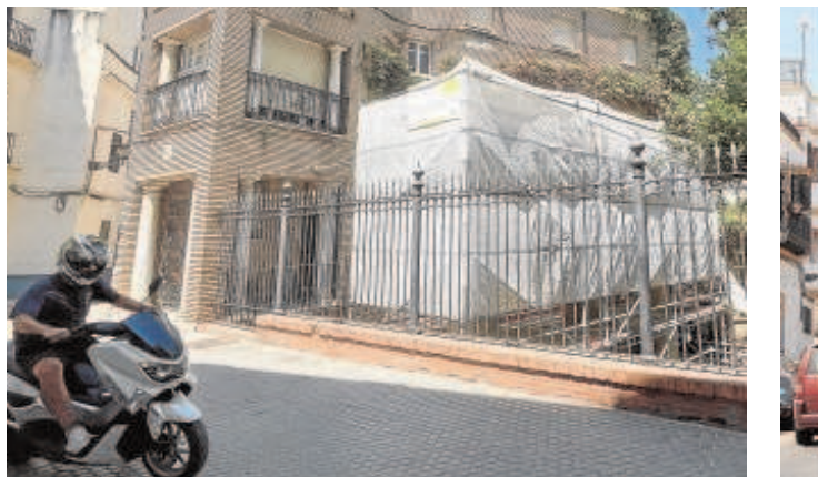
Las columnas de la calle Mármoles, en restauración
