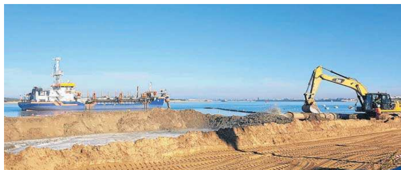
Una draga vierte directamente a través de una tubería los sedimentos en una playa de Sanlúcar de Barrameda.
