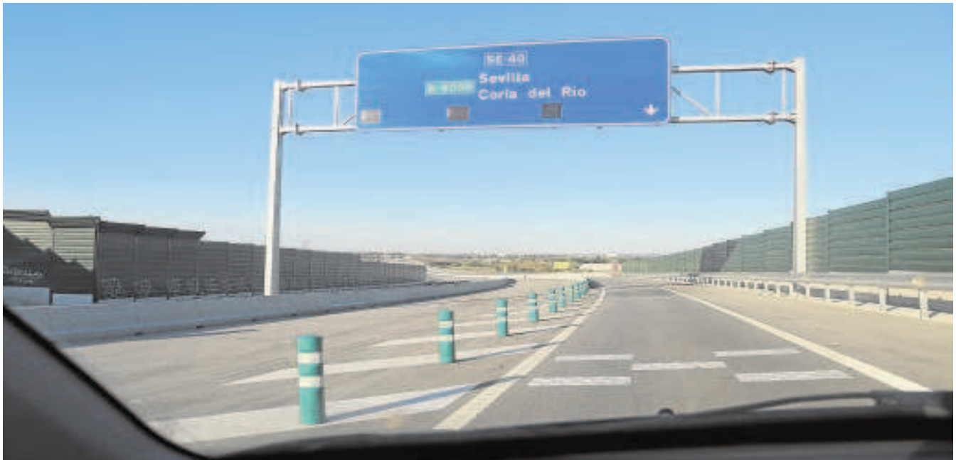
Carril de salida de la SE-40 a su paso por Coria del Río, justo donde acaba la actual circunvalación // ROCÍO RUZ
