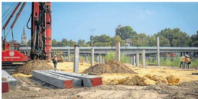
Pilotes prefabricados a la espera de su colocación.
