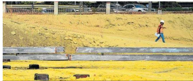
Una vista de los pilotes ya metidos en el suelo y del terreno compactado con albero.
