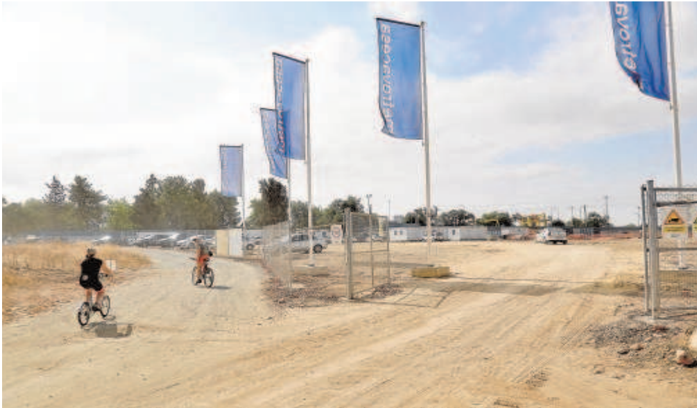
Comienzan los trabajos en las urbanizaciones de Palmas Altas // J.M.SERRANO
