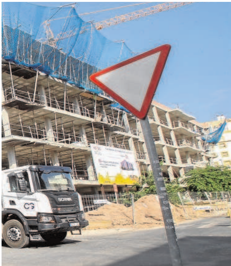
Un trabajador en la obra que promueve la empresa municipal Emvisesa muy cerca de la carretera de Carmona // ROCÍO RUIZ
