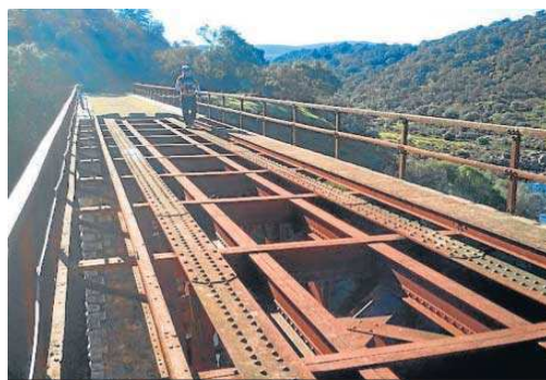
El viaducto del Burro, en El Ronquillo.
