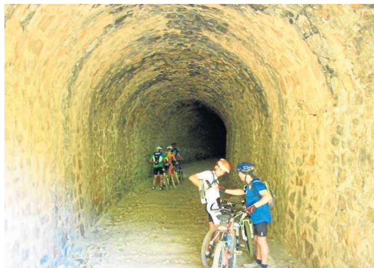
Varios ciclistas en el túnel del Gergal, que se conserva en buenas condiciones, como la mayoría.
