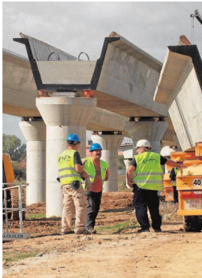
Un tramo de las obras del tranvía de Alcalá // ROCÍO RUZ
