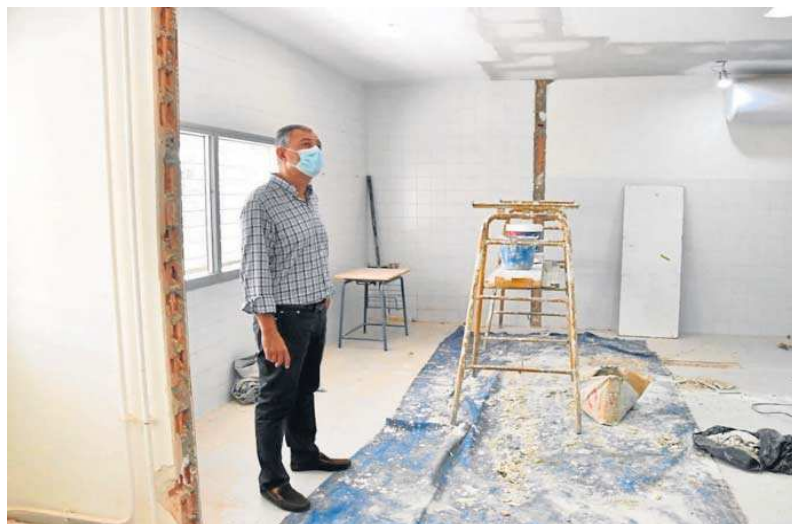
José Luis Sanz observa unas obras en un colegio de Tomares.
