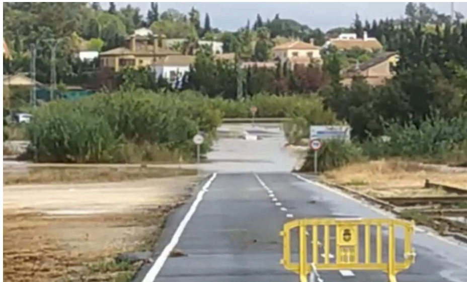
Carretera cortada en Aljaraque. VH
