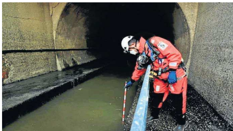
El colector Emisario Puerto en Sevilla.
