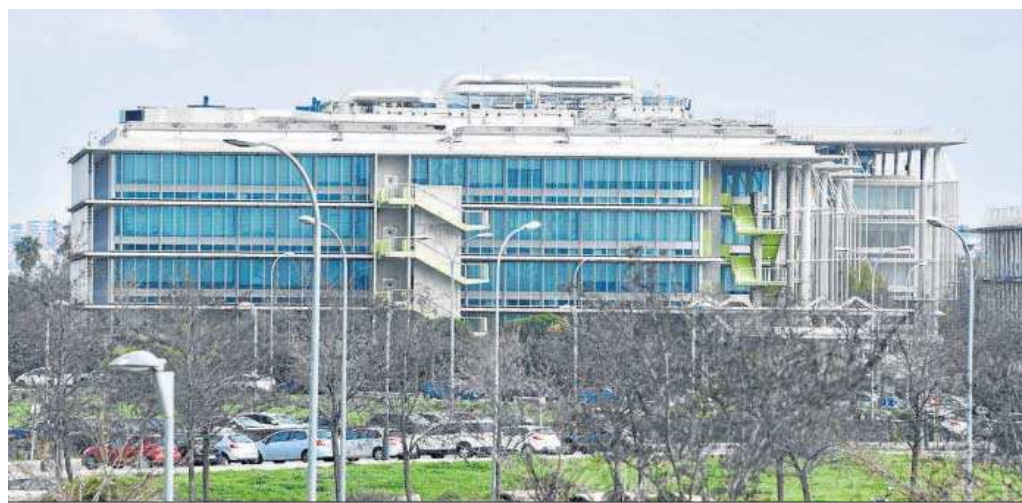
Sede de Abengoa, en el Campus de Palmas Altas, en Sevilla.
