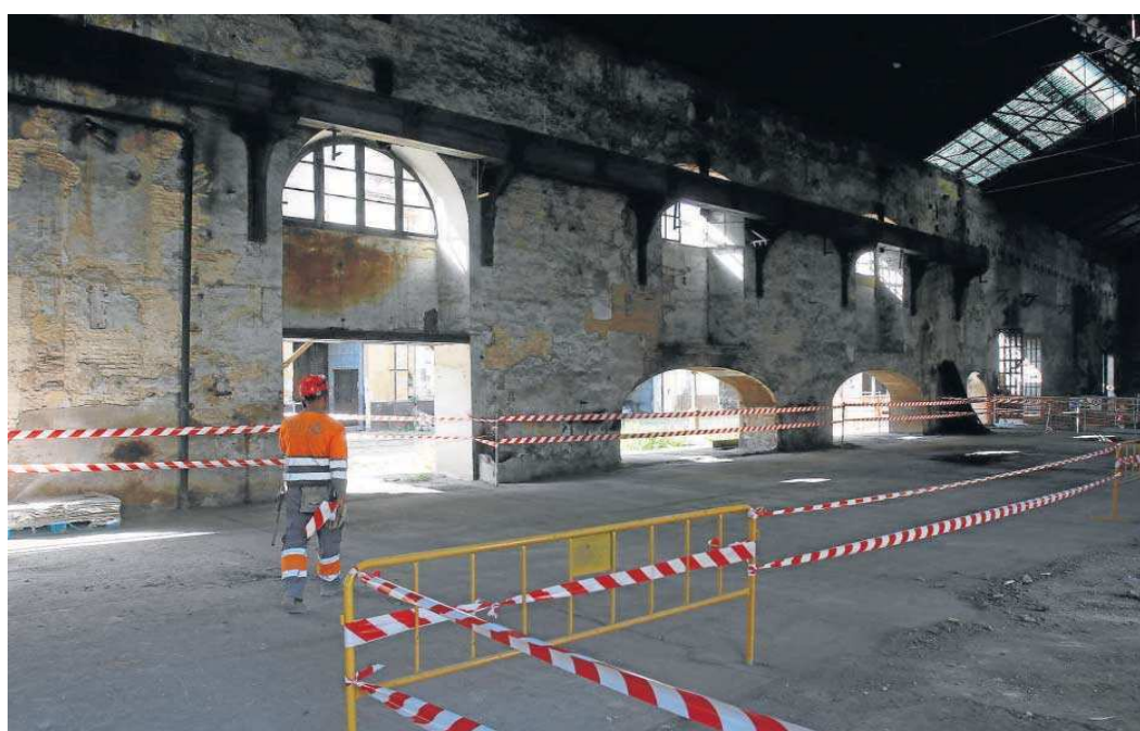
Las obras que se llevan a cabo en la Fábrica de Artillería para instalar el Centro Magallanes. JOSÉ ÁNGEL GARCÍA
