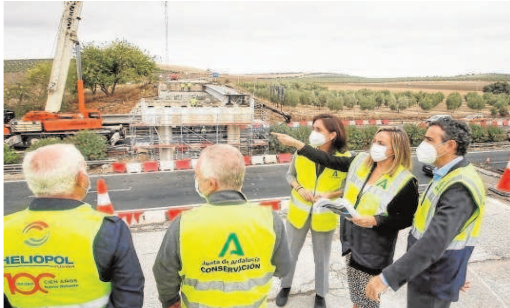
La consejera Marifrán Carazo hace indicaciones sobre el puente en construcción entre Gilena y Pedrera // ABC
