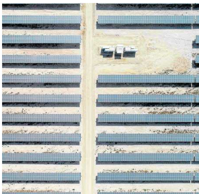
Planta fotovoltaica propiedad de Endesa.
