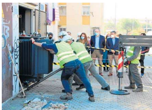
Colocación de un nuevo transformador en el Polígono Sur a finales de 2020.
