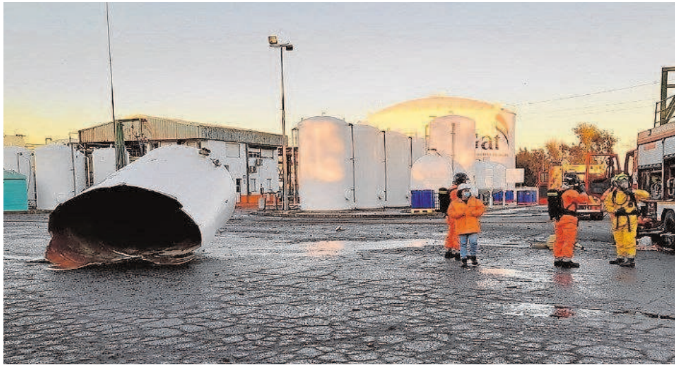
Estado en que quedó el depósito tras la intervención de los bomberos // ABC
