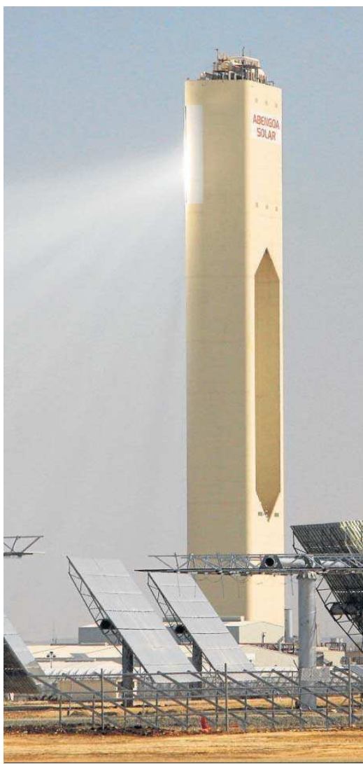
Planta termosolar construida por Abengoa en Sanlúcar la Mayor, en Sevilla.
