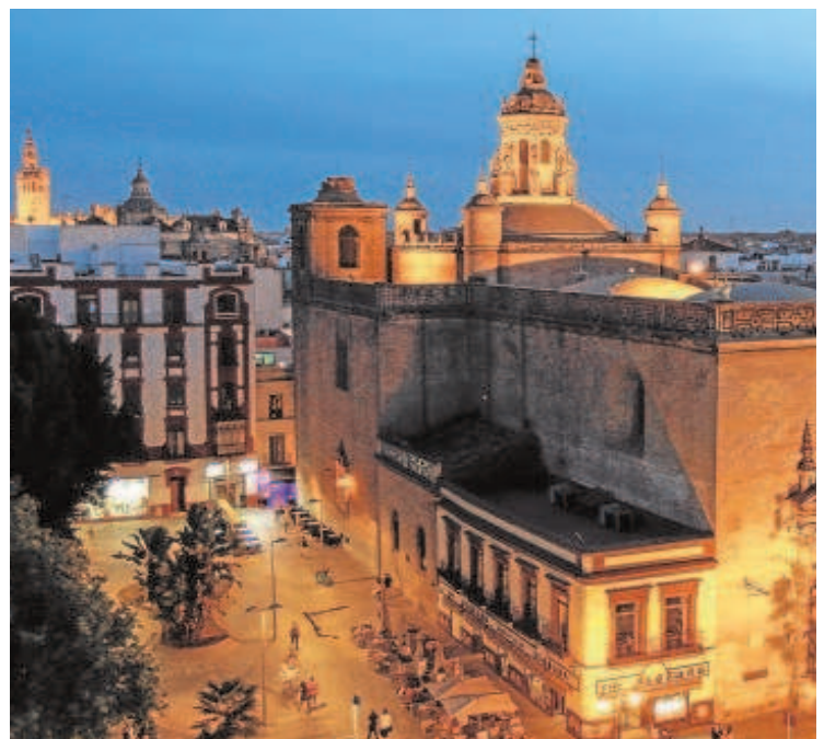
IGLESIA DE LA ANUNCIACIÓN. La Hispalense tiene ya el permiso para iniciar la primera fase de las obras, presupuestadas en un más de un millón // R. DOBLADO
