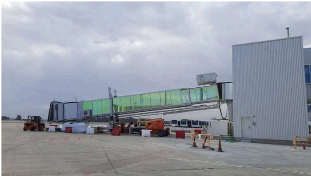
Proceso de sustitución de la primera pasarela de embarque de San Pablo. / Aena
