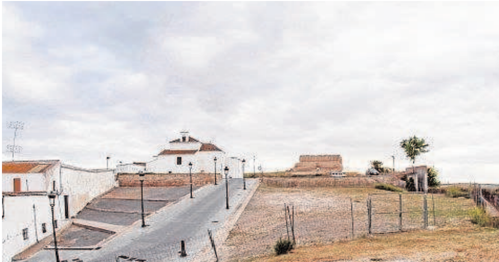
El espacio ha permanecido cerrado por obras desde hace 18 años // ABC
