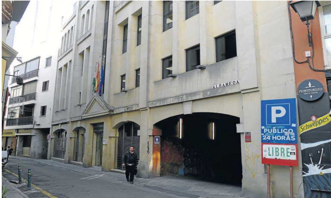
Fachada de uno de los edificios que miran a la céntrica calle Albareda.
