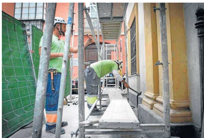
Albañiles trabajando en una obra en Sevilla.
