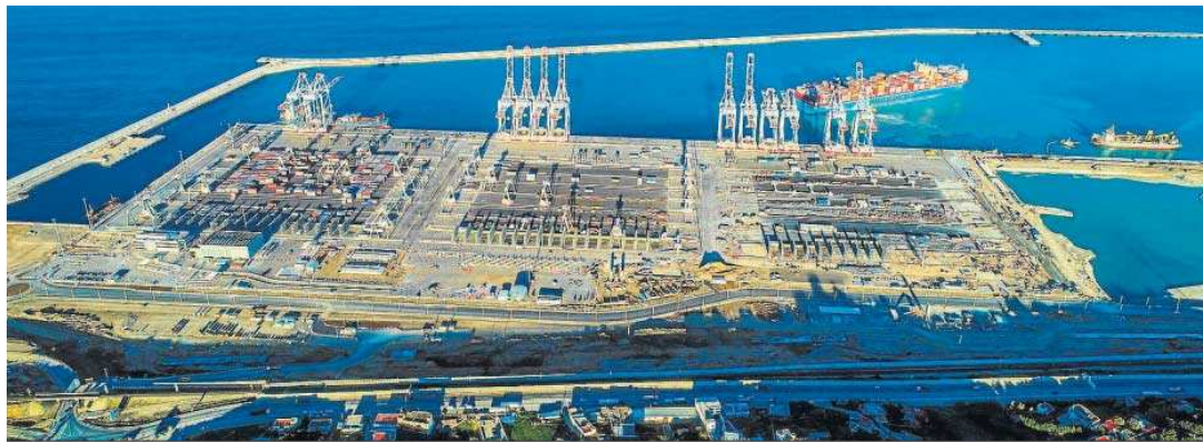
La terminal de APM Terminals MedPort Tangier, en Tánger-Med 2.
