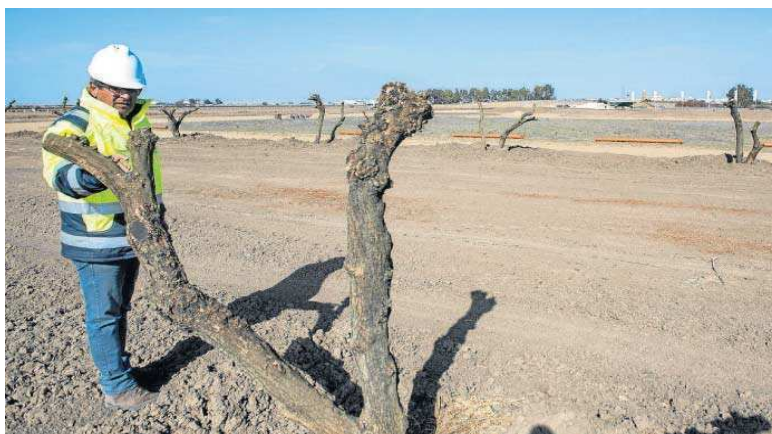
Las obras de urbanización ya se han iniciado en estos terrenos de la marisma del Guadalquivir. FOTOS: JUAN CARLOS VÁZQUEZ
