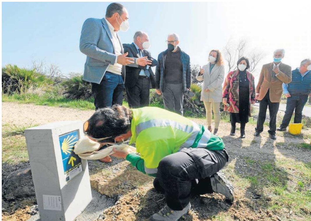
Instalación de las señalizaciones.
