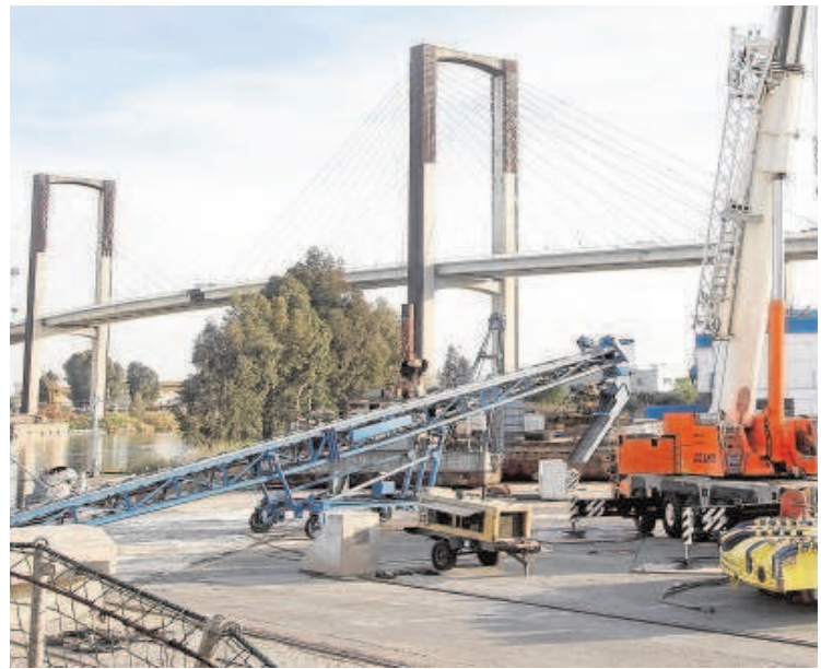
Piezas de la tuneladora que llegaron en barco hasta el Puerto de Sevilla en marzo de
