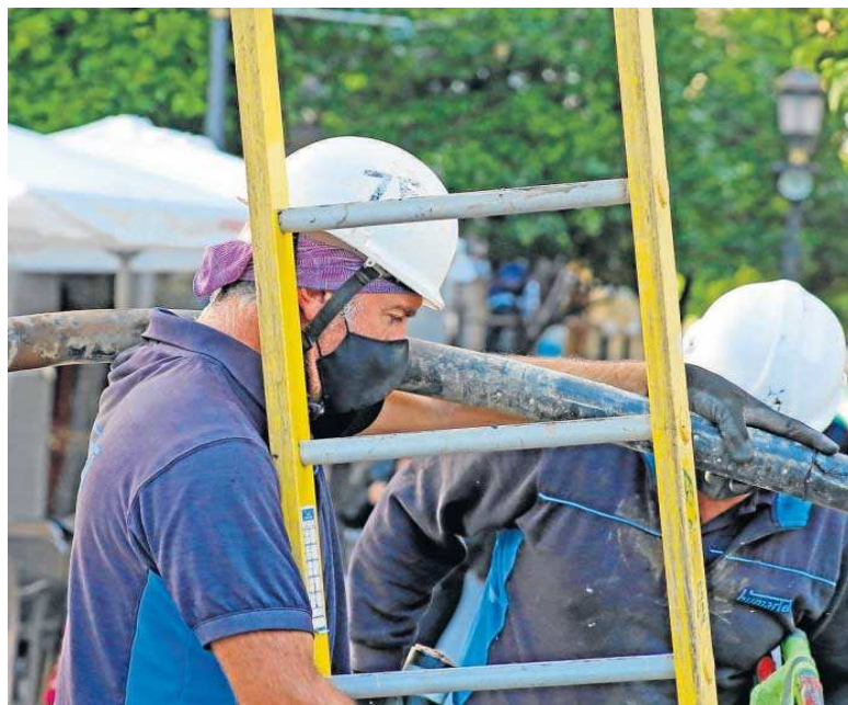
Trabajadores de la construcción en una obra.
