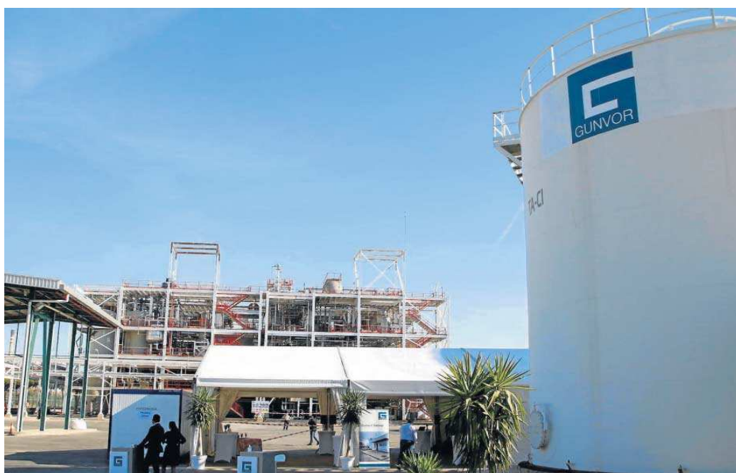
Instalaciones de la empresa energética Gunvor en Palos de la Frontera.
