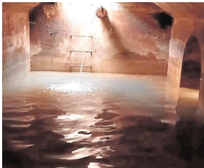
Uno de los aljibes que va a recuperar el municipio de Cantillana // ABC
