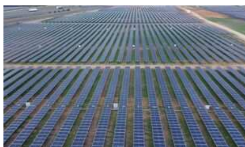
Imagen de la planta fotovoltaica de Endesa Torrepalma.
