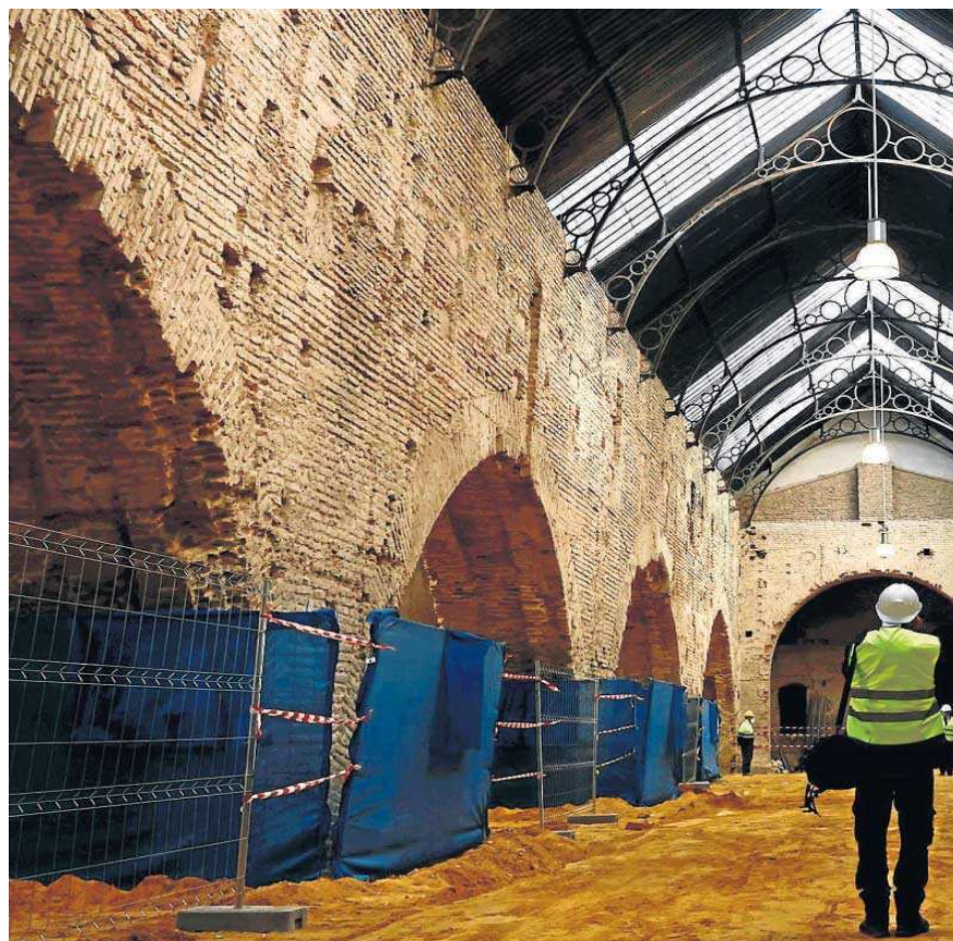
Los grandes arcos de las Atarazanas Reales ya protegidos para unas esperadas obras de rehabilitación que ya han arrancado.
