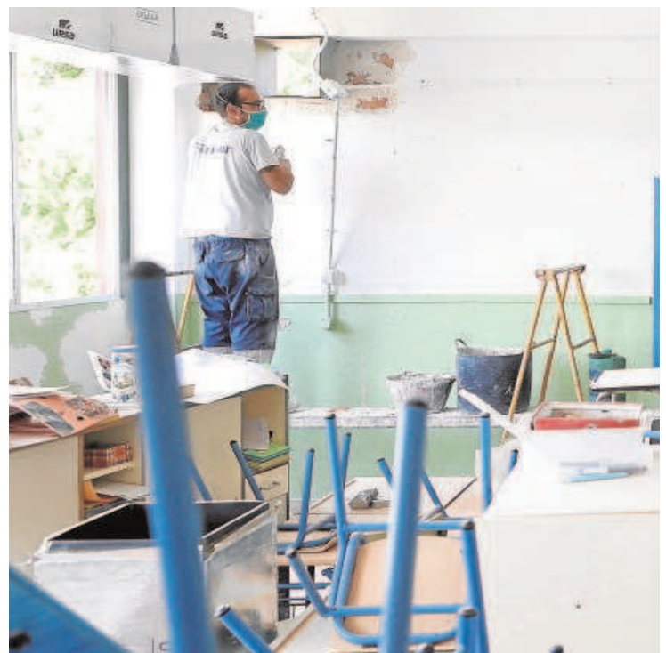
Obras de instalación de aparatos de aire acondicionado en el colegio Fernán Pérez de
