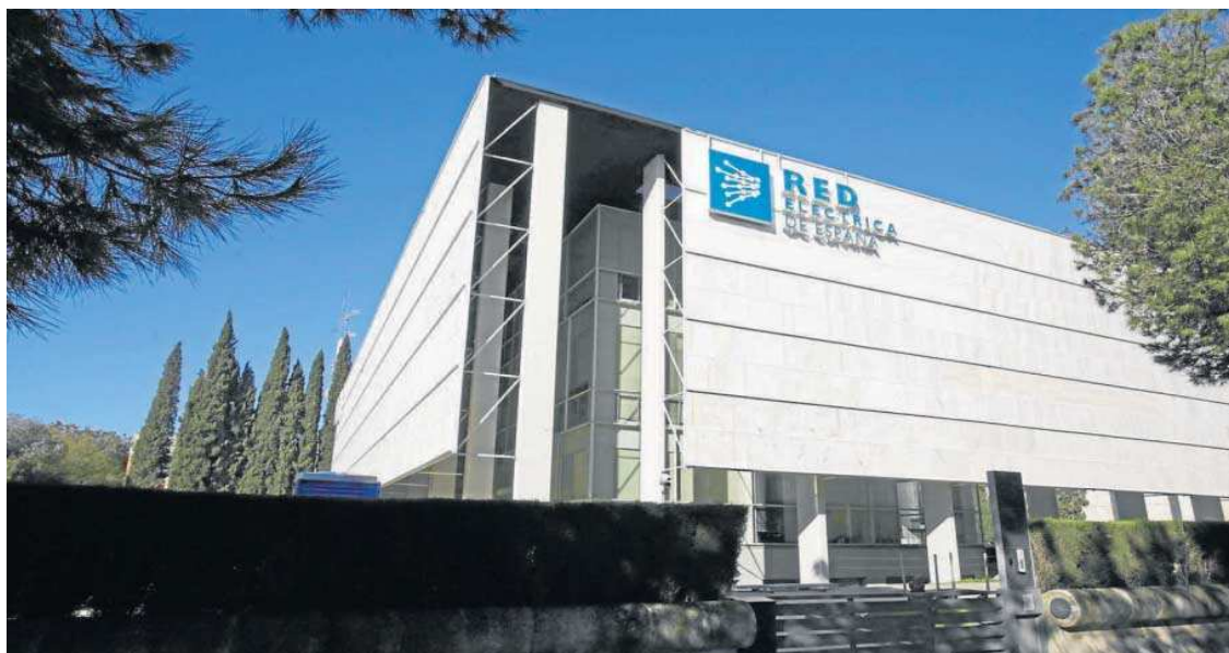
Instalaciones de Red Eléctrica Española en Sevilla.
