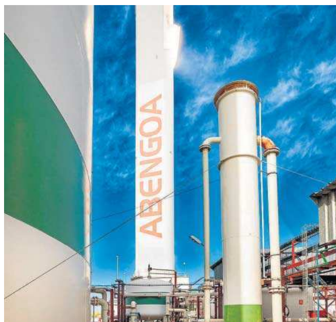
Planta termosolar construida por Abengoa en la provincia de Sevilla.
