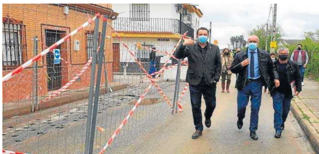
Muñoz visita el inicio de obras en una de las calles de Valdezorras Este. M. G.
