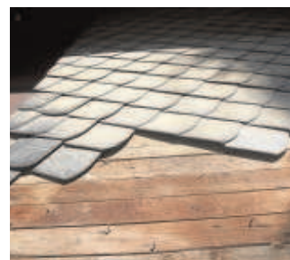
Arriba, algunas de las siete torres que perforan la cubierta del pabellón de Hungría, que sufre la pérdida de tejas de pizarra. Abajo, estado de la madera exterior del edificio // FOTOS: ROCÍO RUZ
