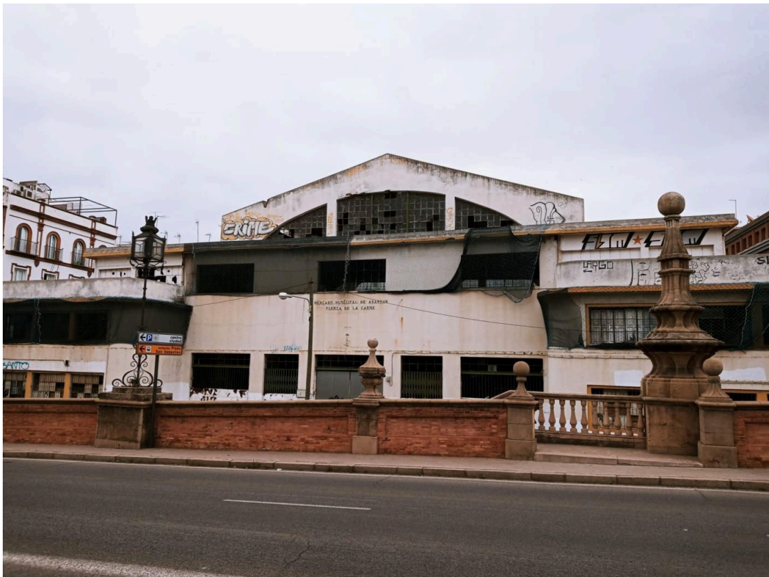
Fachada principal del Mercado de la Puerta de la Carne. ALFREDO GUARDIA
