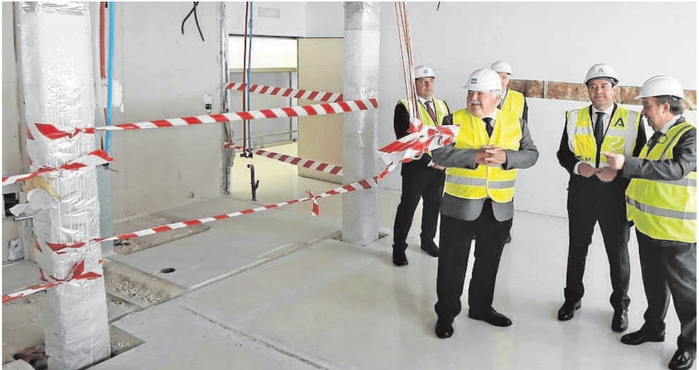
Jesús Aguirre, Juanma Moreno y Miguel Colmenero, director gerente del Virgen Macarena, inspeccionando ayer las obras del futuro centro sanitario // RAÚL DOBLADO
