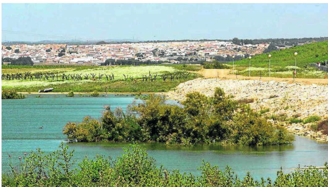
Vista de Gerena desde el embalse de agua para abastecimiento de la planta de elaboración de cobre.
