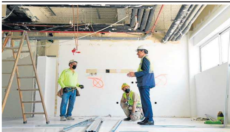
Juanma Moreno durante la visita a las obras de la primera fase del Hospital Macarena-Cartuja.
