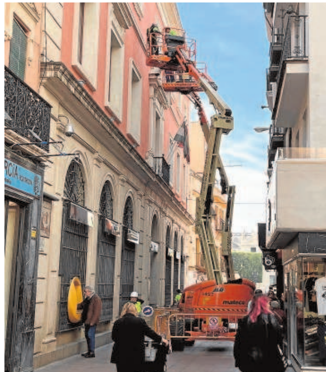
Primeros trabajos para colocar los toldos, ayer en la calle Sierpes // MANUEL GÓMEZ
