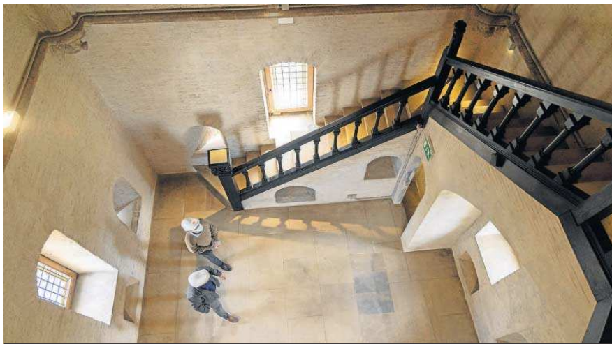
Una de las plantas de la Torre de Don Fadrique completamente restaurada.
