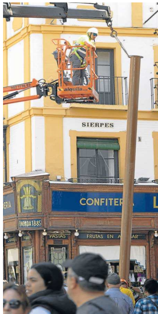
Un operario instala una estructura para los toldos en la plaza de la Campana. ANTONIO PIZARRRO
