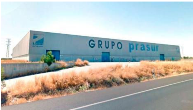
Estado actual de a antigua nave de Prasur.
