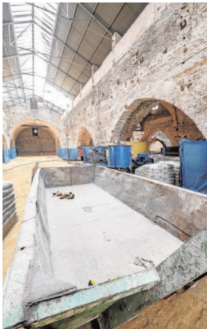
Las obras en las Reales Atarazanas ya han comenzado // J.M. SERRANO
