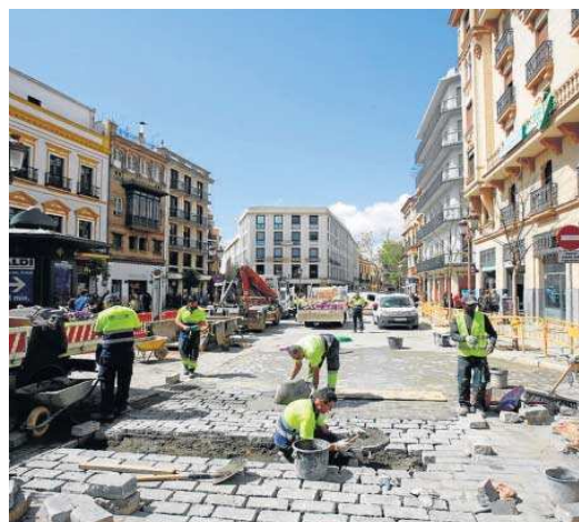
Reparación del pavimento de la Campana.
