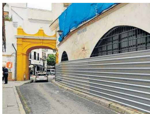
Vallas en la calle Arfe que han sido retiradas.
