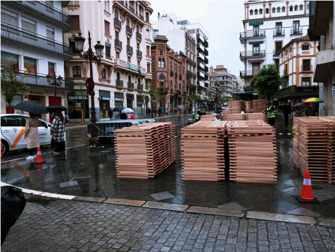
La Campana ha quedado cortada al tráfico este martes para proceder a la instalación de las sillas.
